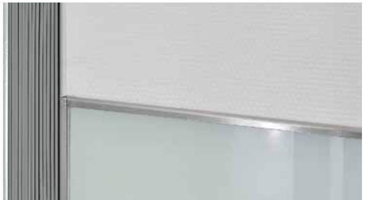
Integration einer Dehnungsfuge und vertikales Abschlussprofil
