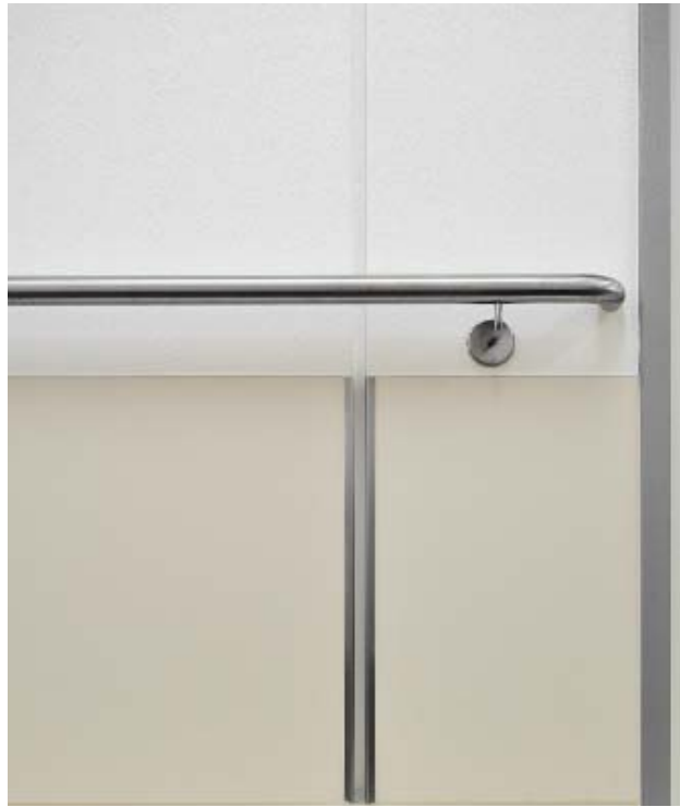
Integration einer Dehnungsfuge
